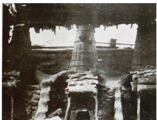
「三井」在三角湧的製腦所，已採用新式腦灶煉腦。（引自《臺灣寫真帖》，中央研究院臺灣史研究所檔案館／提供）
