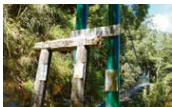
新尚吊橋新舊橋門並立。
