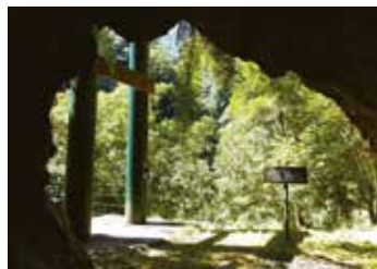
沙敦隧道與隧道口的石洞吊橋。沙敦隧道是越嶺道東段主線唯一的隧道。
