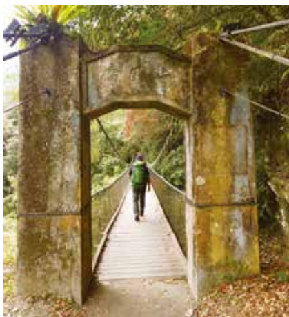
山風二號橋舊名「山風橋」，保留了 1930 年代的老橋門。
