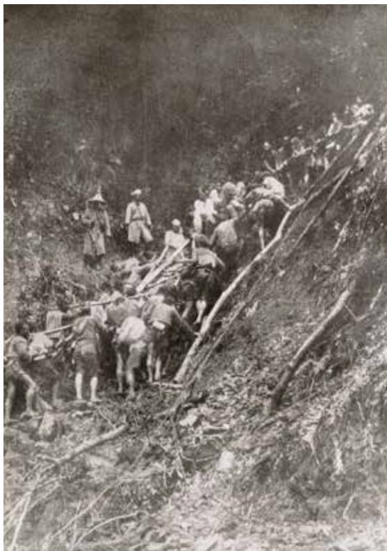
日方運砲上陡坡。（引自《臺灣蕃族寫真帖》，中央研究院臺灣史研究所檔案館／提供）
