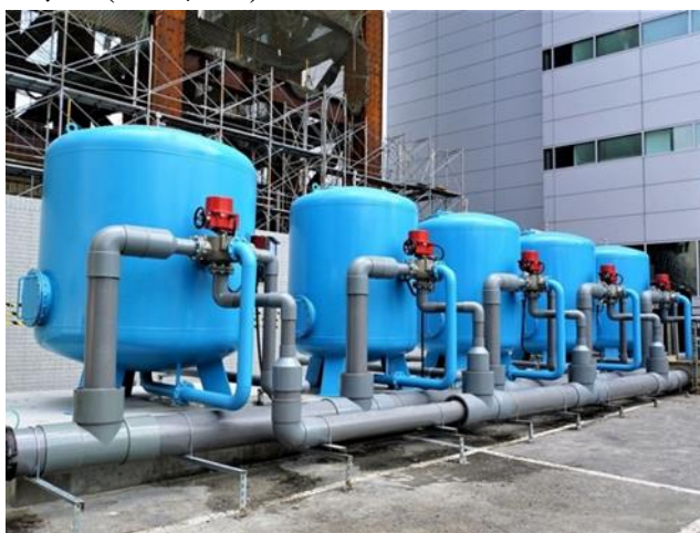
圖 19 建築工地地下水利用
