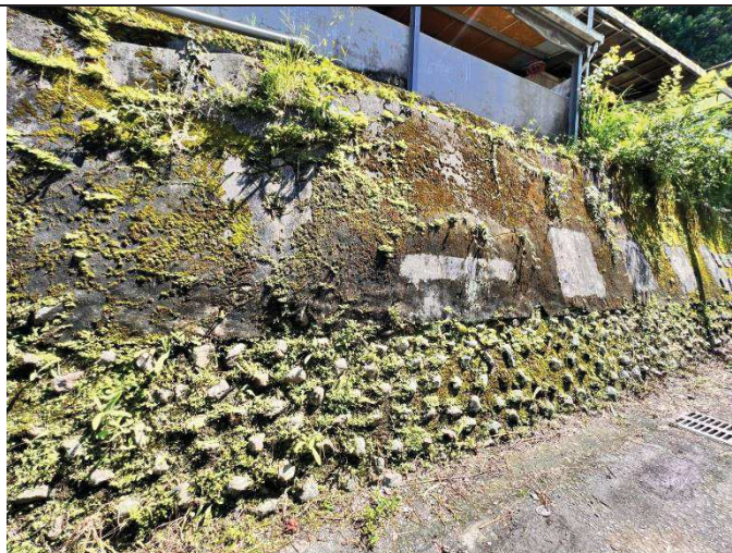
工程項目: 擋土牆結構補強、40*40 暗溝 拍攝日期:111 年 9 月 受益對象: 瓦祿部落居民 拍攝座標:E:254077.489 N:2721569.862 (TWS97) 121.040266,24.600860 (WGS84)
