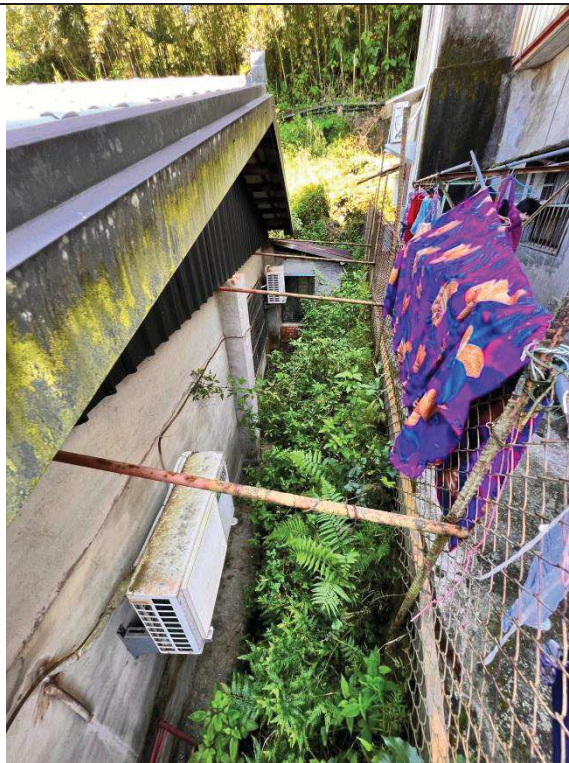
工程項目: 30*30 HDPE 排水溝 拍攝日期:111 年 9 月 受益對象: 瓦祿部落居民 拍攝座標:E:254077.081 N:2721572.427 (TWS97) 121.040262,24.600883 (WGS84)
