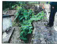
A工區現況照片
