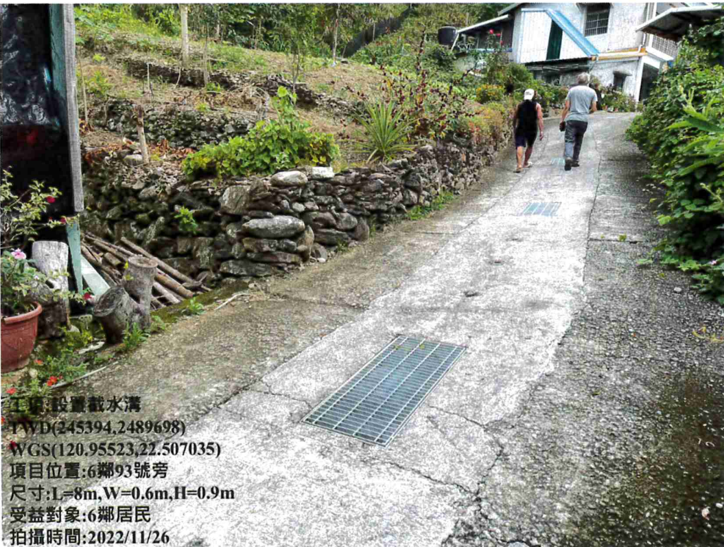
工項:設置截水溝 FWD(245398,2489709) WGS(120.955269,22.507134) 項目位置:6鄰93號旁 尺寸:L=8m,W=0.6m,H=0.9m 受益對象:6鄰居民 拍攝時間:2022/11/26
