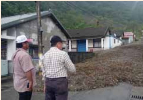
臺東大武鄉愛國蒲部落土石流災情
