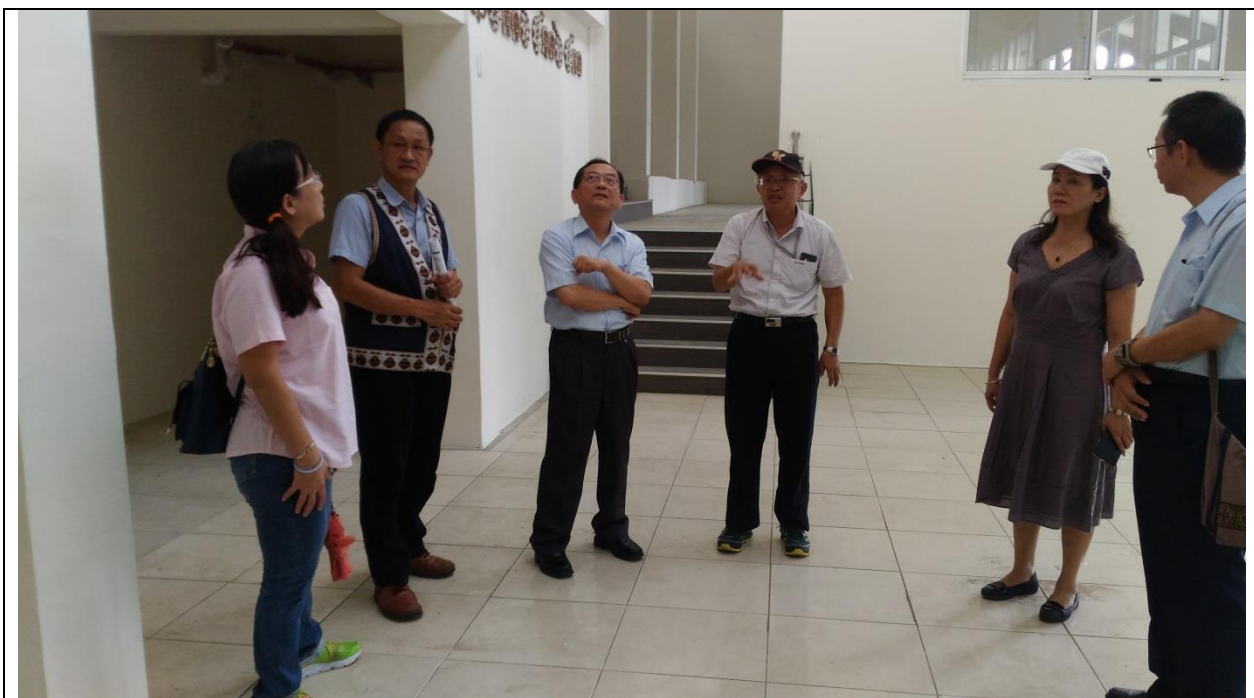
鍾副主任委員(圖左 3)率隊赴文發中心主持個案計畫期中查證作業實地勘查 ~娜麓灣區餐飲中心內部設施設備整修更新工程(二)
