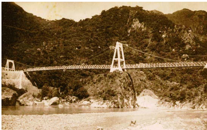
第一代東河橋，原名「吉田橋」，建於1926年，是可供汽車行駛的鐵索吊橋。（引自《東臺灣展望》）
