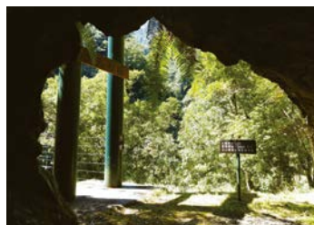
沙敦隧道與隧道口的石洞吊橋。沙敦隧道是越嶺道東段主線唯一的隧道。
