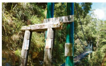
新尚吊橋新舊橋門並立。
