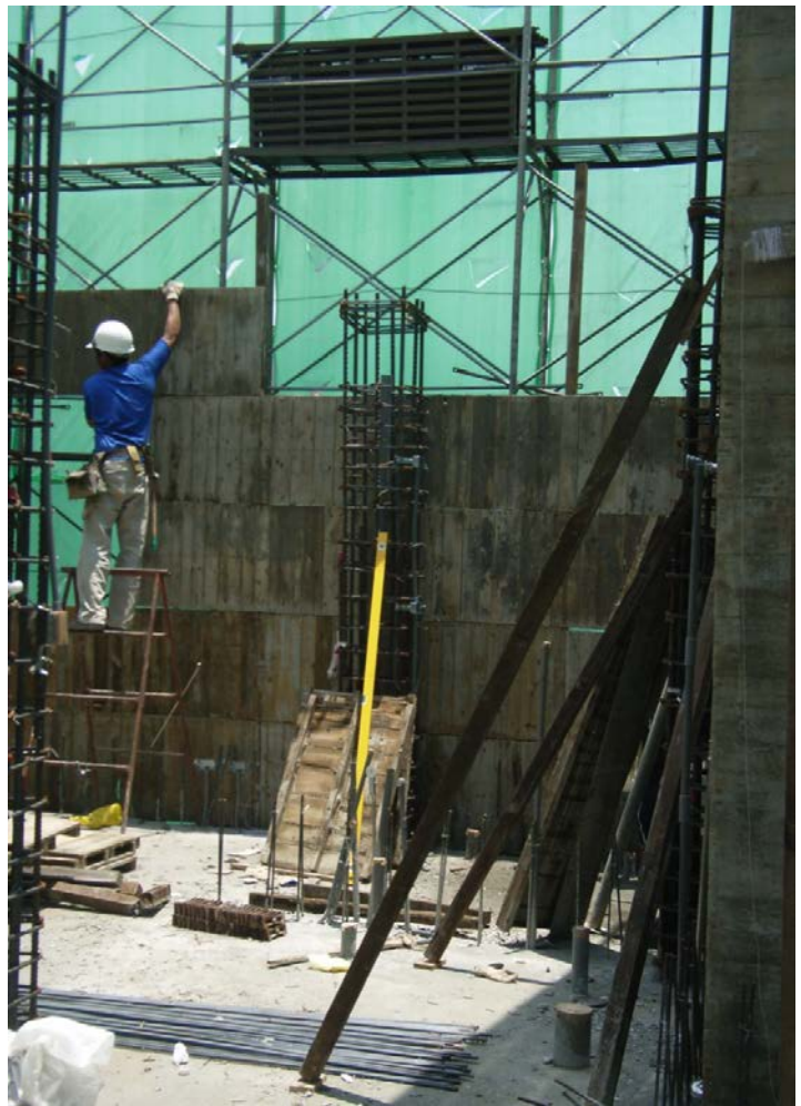
圖 2：都市阿美族板模師傅正在工地現場從事立模作業。（資料來源：楊士範 攝於 2010.7.14。）
